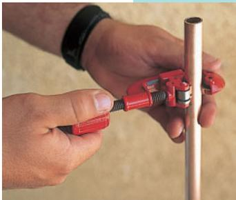
**1. Positionner le tube de cuivre sur les rouleaux du coupe-tube et serrer la poignée jusqu'à ce que la molette entre en contact avec le tube.**
